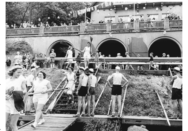
Das 1924/25 für den Ruderverein Bamberg erbaute Bootshaus in der Wolfsschlucht (Oberer Leinritt 70), hier nach der Wiederaufnahme des Ruderbetriebs: Bootstaufe im Juli 1949. Das Gebäude wurde jedoch bereits 1952 in eine Jugendherberge des DJH umgenutzt
